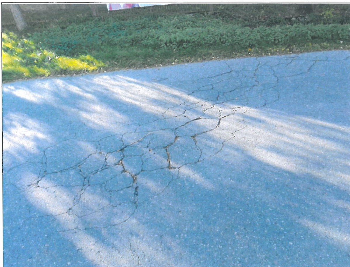
Pęknięcie w nawierzchni drogi (październik 2019)
